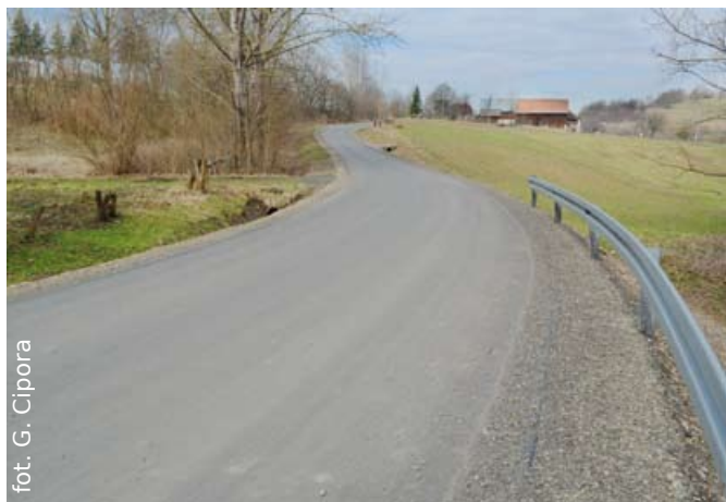
Nowy odcinek drogi do Mrzygłodu
