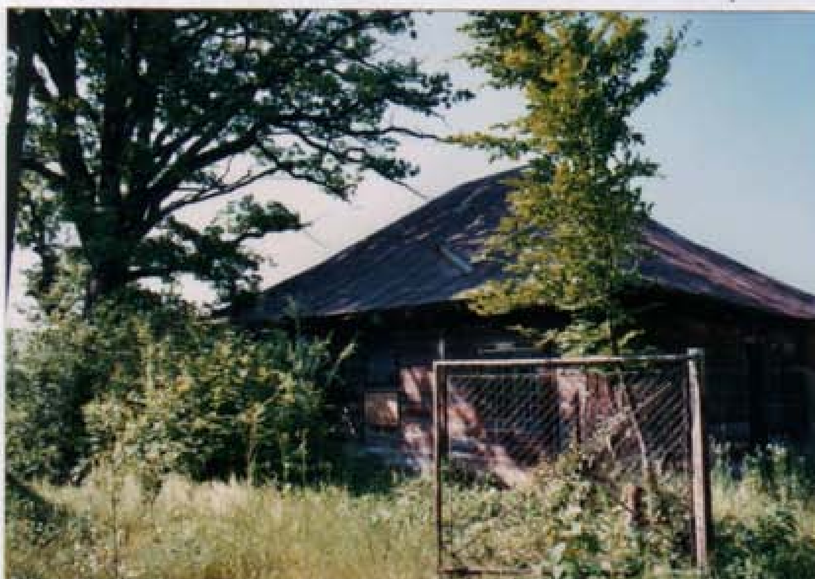
Elewacja boczna (południowa) 4-osiowa, z usytuowanym centralnie bocznym otworem wejściowym z podcieniem i drewnianą szopą nakrytą eternitem, dostawioną wzdłuż lewej strony elewacji płd. w latach 50 tych XX wieku. Spełniała ona funkcję czyszczarni i zaprawialni zbóż.
