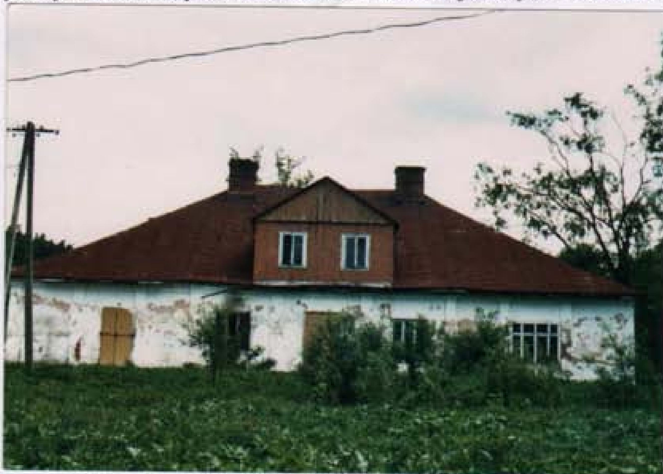
Elewacja tylna (zachodnia).
