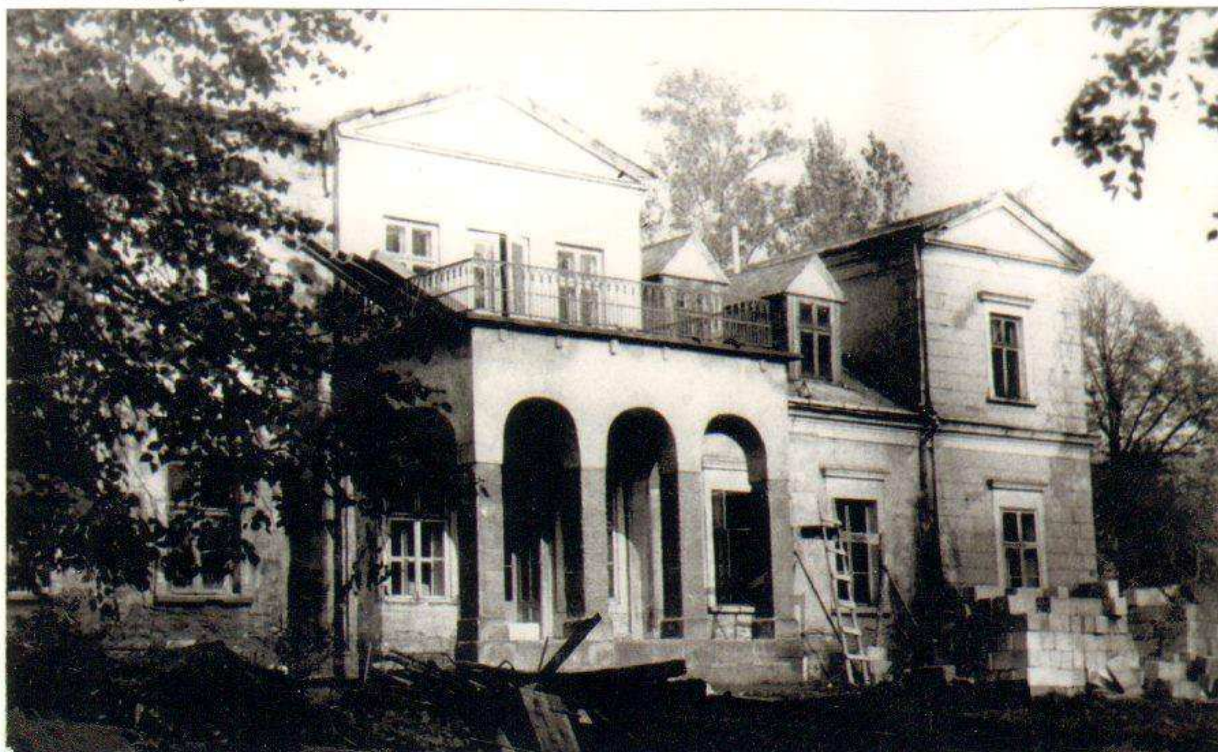
Elewacja frontowa - wschodnia - w trakcie remontu w 1972 r.
