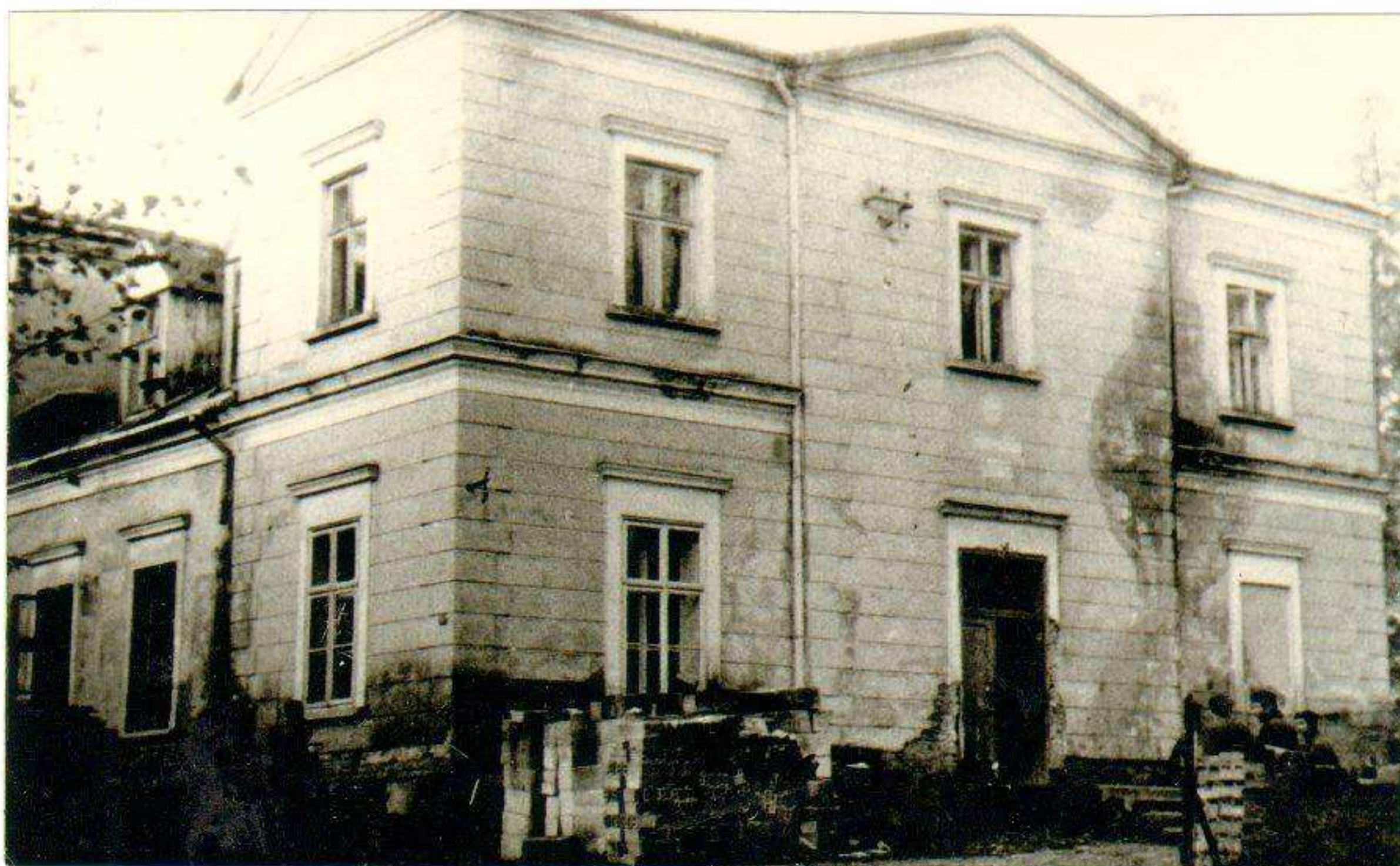
Elewacja boczna - północna - w trakcie remontu w 1972 r.
