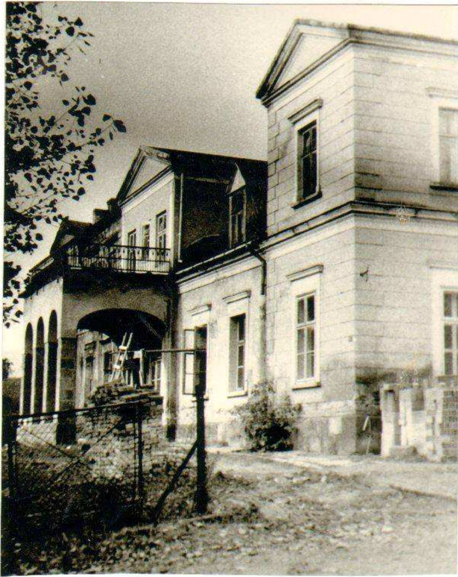
Elewacja frontowa dworu w trakcie remontu w 1972 r.
