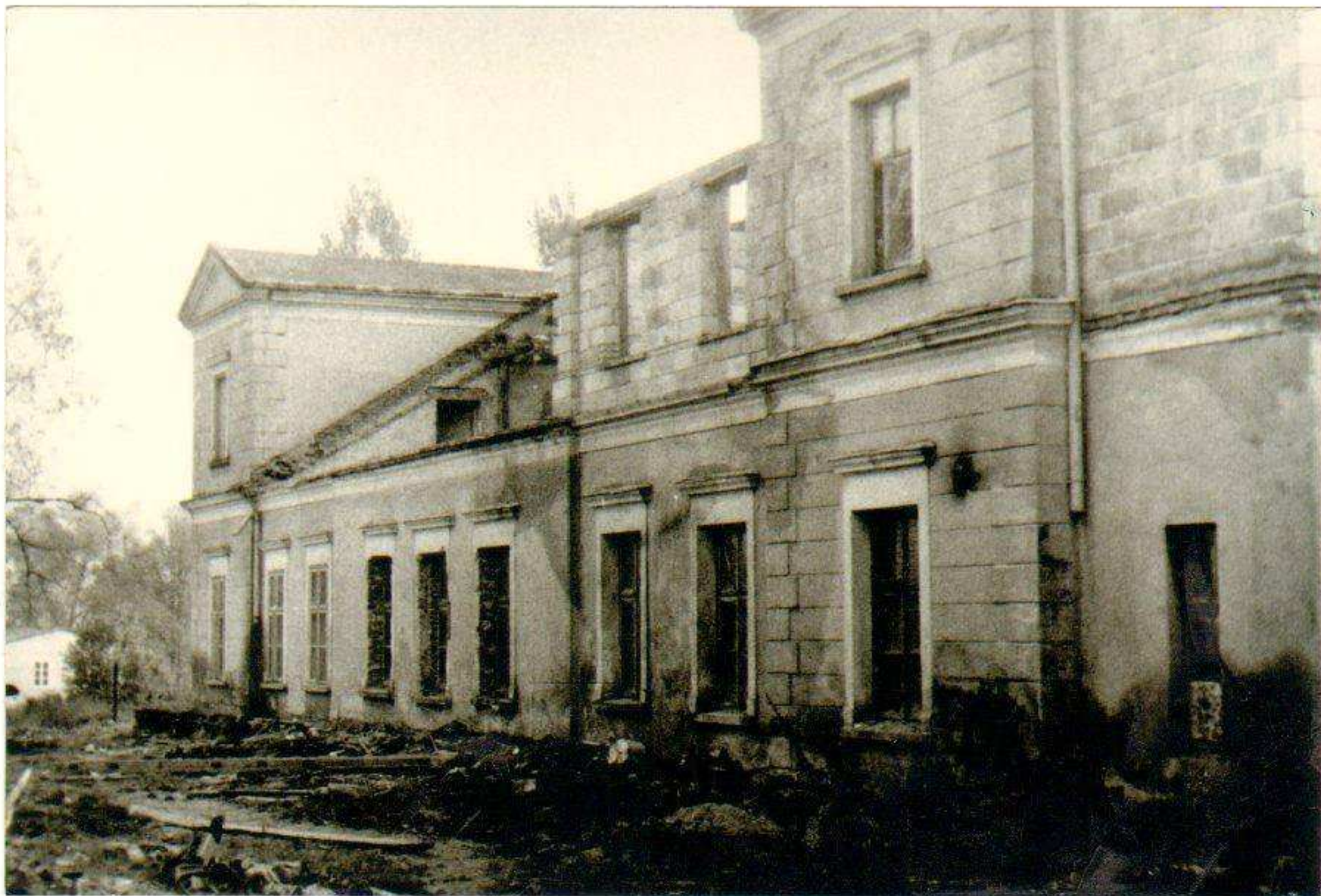
Elewacja tylna dworu - zachodnia w trakcie nadbudowy w 1972 r.
