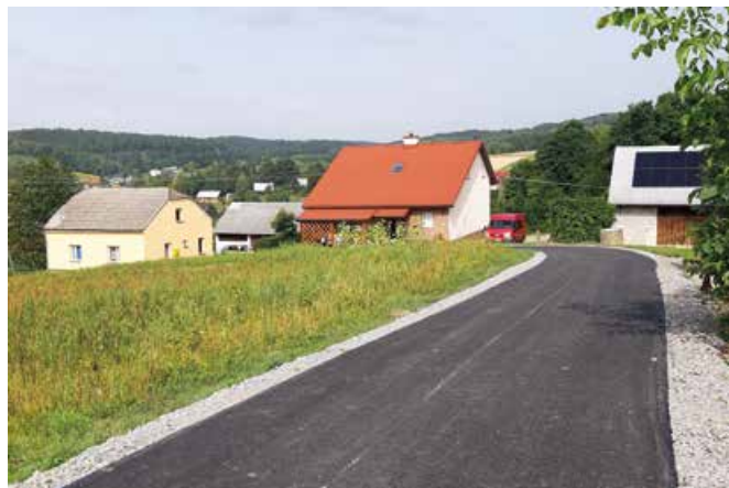
Wyremontowana droga w Niebocku
