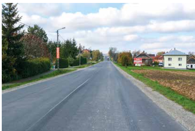
Wyremontowana droga wojewódzka w Dydni
