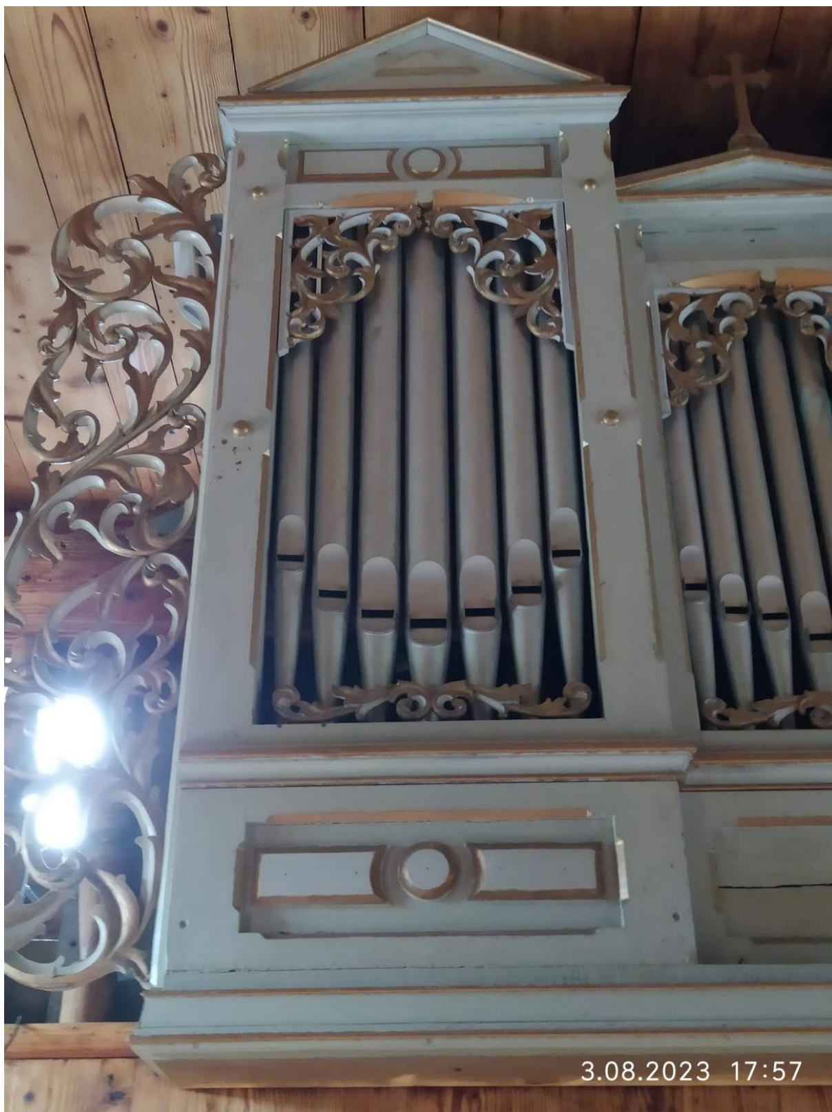
Fot. 2. Końskie, Kościół Parafialny p.w Przemienienia Pańskiego, prospekt organowy, fragment. Stan przed konserwacją. Fot. Ks. Andrzej Pilch, sierpień 2023.
